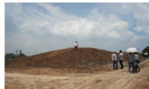
4月 初期に造られた土手の上に1メートルの深さの表土混合物が敷かれています。
