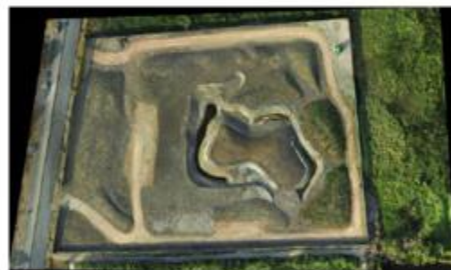
6ヶ月目 整地工事が完了し、苗木を植える準備が整いました。
