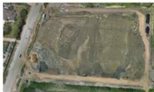
2ヶ月目 敷地の初期土工では、既存の土壌を掘削するとともに、指定された人工土壌と混合する必要がありました。
