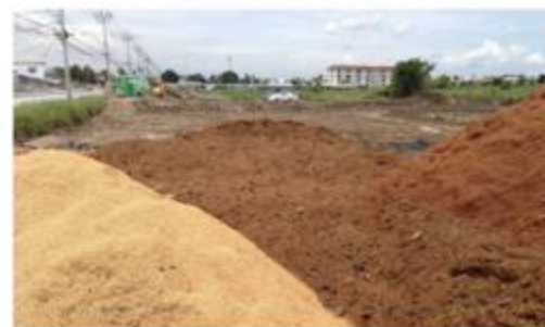
3ヶ月目 圧縮を防ぎ、設計された土壌の多孔性を可能にするために、非常に肥沃な人工土壌が敷地内に輸入されました。
